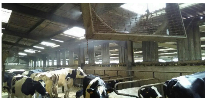
► Utilisation de brumisateurs en bâtiment
